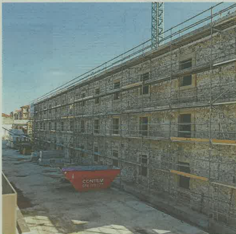
Obras en el edificio de Tabacalera. CAROLINA SANTOS
