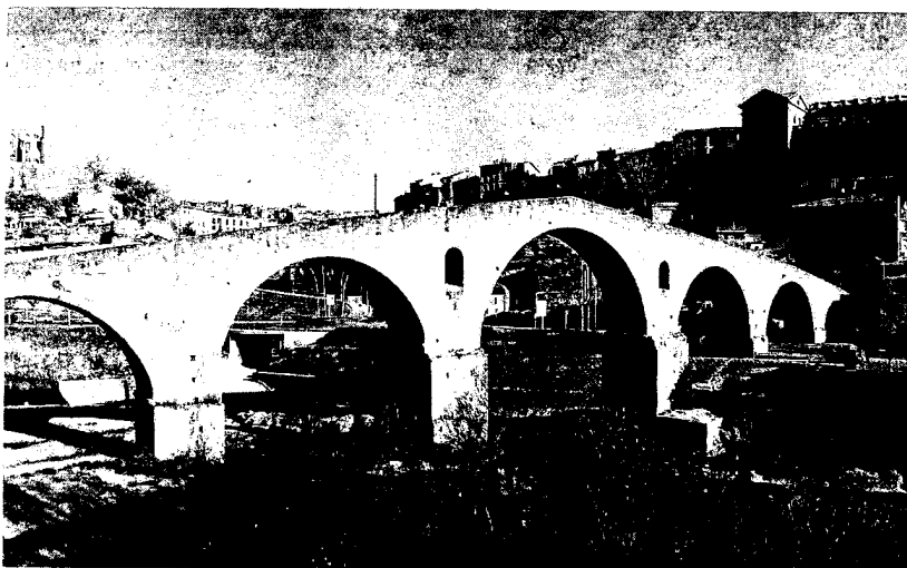
El puente medieval de Manresa. Fotos: N.G.
